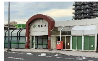
【南仙台駅 駅舎】
