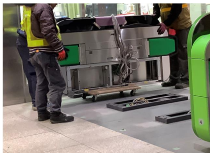
自動改札機取替工事
