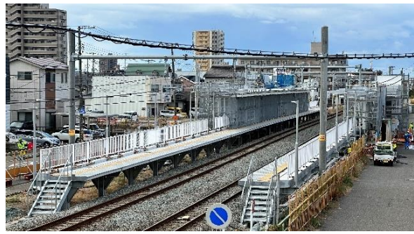
工事状況（2024年11月）
