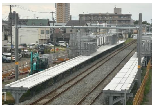
ホーム設置状況（2024 年 9 月撮影）
