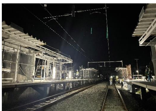
屋根工事状況（2024 年 9 月撮影）
