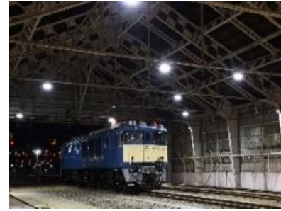
庫内照明（夜間）
