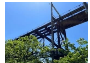
旧立場川橋梁
