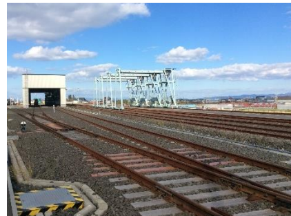
【保守基地外観】
