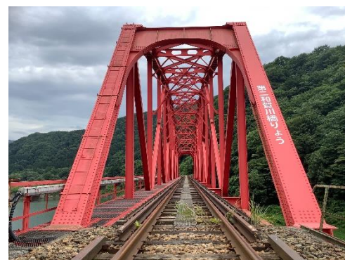
第2和賀川橋梁
