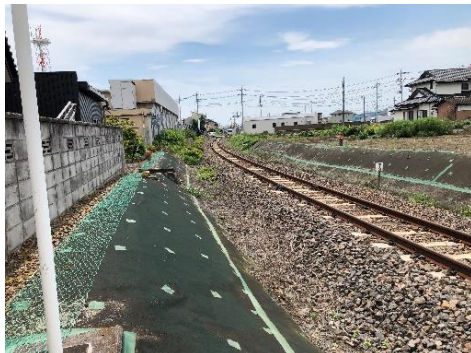
防草シート敷設
