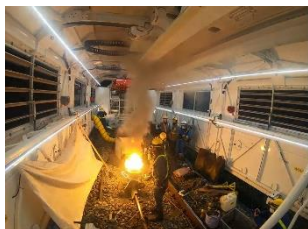
車両内での溶接作業
