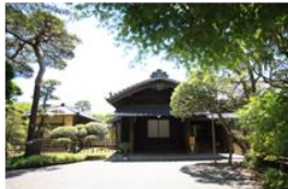
旧堀田家住宅(旧堀田邸)
