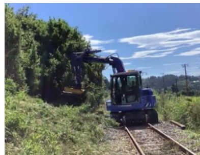
支障樹木伐採作業
