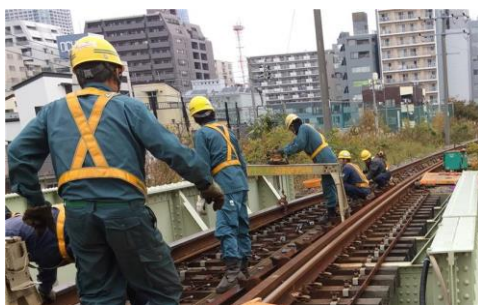
レール交換工事
