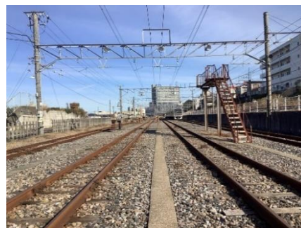
JR成田駅構内電留線
