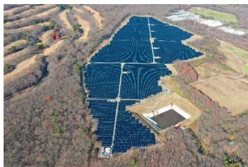
池田太陽光発電所（栃木県）
