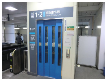
エレベーター
