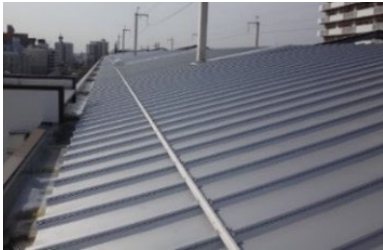
屋根飛散・落下防止対策（金属屋根）
