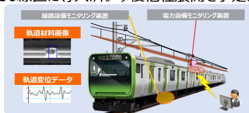
CBM（地上設備モニタリング）
