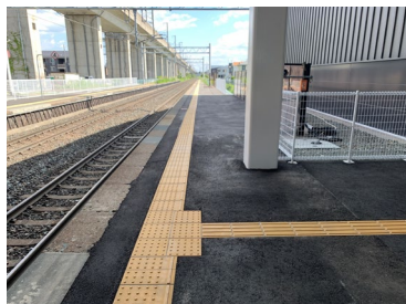
視覚障害者誘導用ブロック
