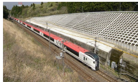
切取りの面工（吹付枠工）
