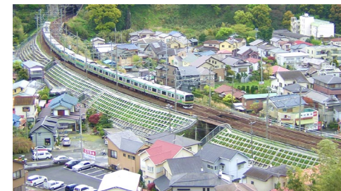
盛土のり面工（吹付砕工）
