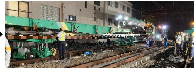
大型機械作業
