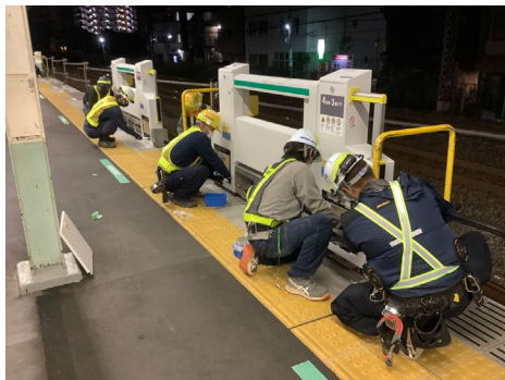
ホームドア工事
