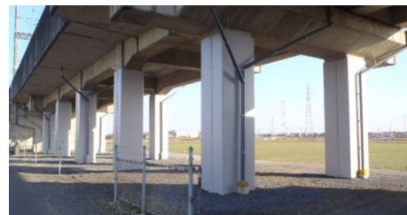
大規模地震対策（新幹線高架橋柱）
