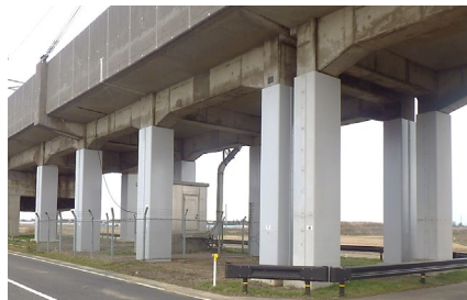
高架橋柱耐震補強
