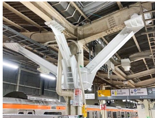
スマートボックス®工法 (武蔵野線西船橋駅)
