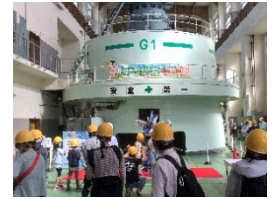
発電機設備見学
