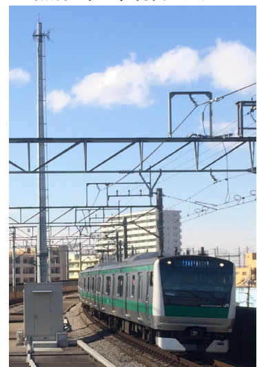
【JR 東日本】 ATACS 無線式列車制御システム
