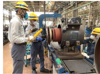
【主電動機整備作業】
