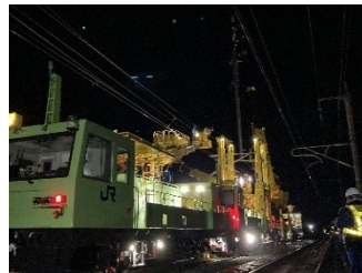
大規模地震対策（新幹線電柱）
