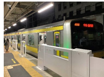
ホームドア整備
