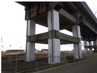
大規模地震対策（新幹線高架橋柱）
