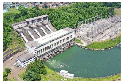
信濃川発電所 (発電機器老朽取替)
