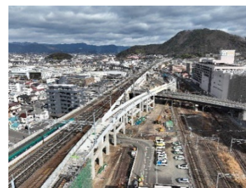
福島駅アプローチ線の増設工事
