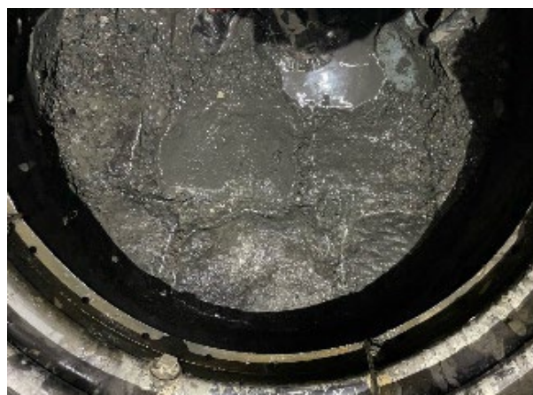
確認箇所②の状況(上面からの撮影)
