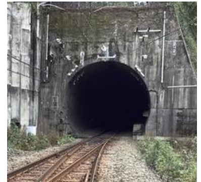
伊東線 新宇佐美トンネル (網代駅側)
