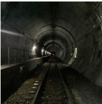
新宇佐美トンネルの内部
