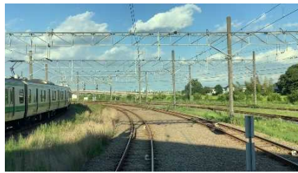
川越車両センター構内
