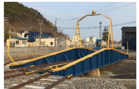
釜石駅転車台
