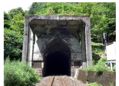
第二大橋トンネル排煙装置跡
