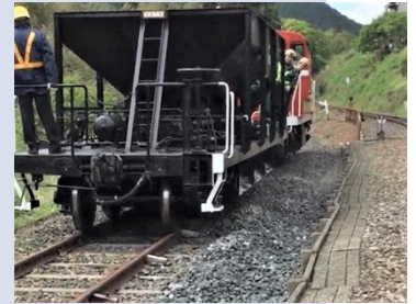
碎石散布の様子
