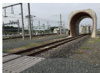
▲模擬トンネル
