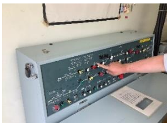
▲転てつ器転換試験 (制御盤)
