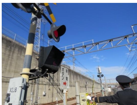
【踏切非常ボタン】
