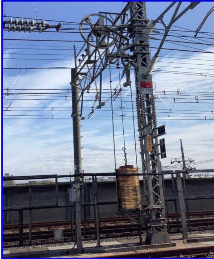
滑車式自動張力調整装置 (WTB)
