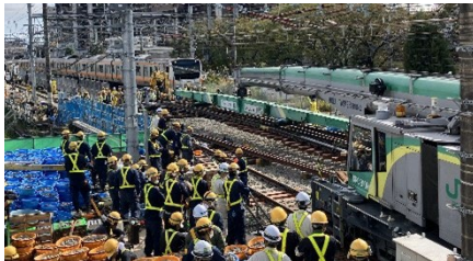
高尾駅線路切換工事
