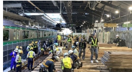
渋谷駅線路切換工事
