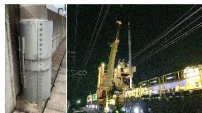
新幹線電柱の耐震補強
