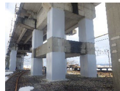
新幹線高架橋柱の耐震補強
