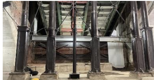
新橋駅 工事ヤード
