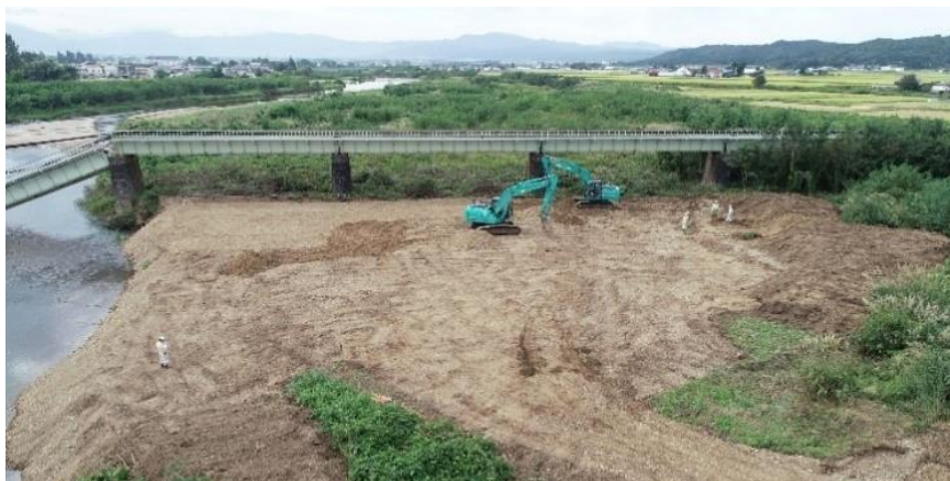
作業ヤードの造成（9/22 撮影）
