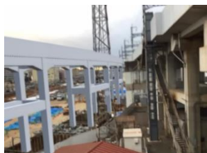
ARによる3D設計モデル（高架橋）の 現場見学（イメージ）
