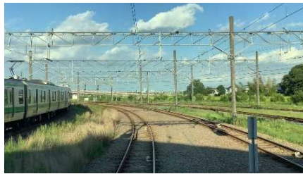
川越車両センター構内
