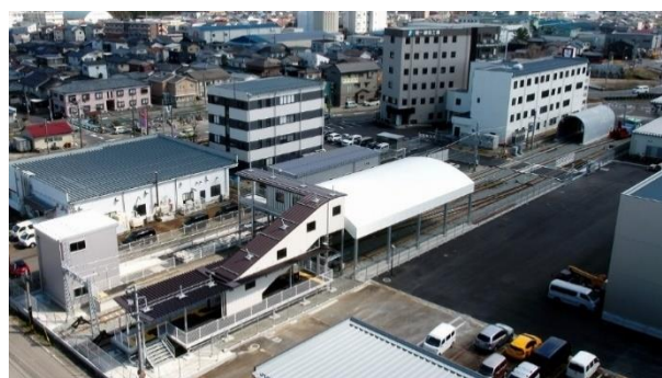
(第一建設工業(株) 亀田研修センター)
