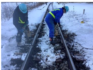
突き固め作業の様子
