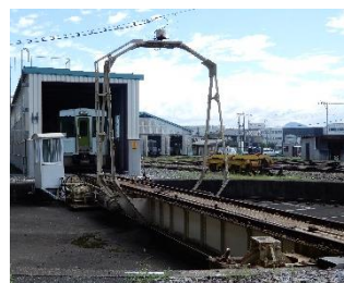
【一ノ関運輸区構内 転車台】
