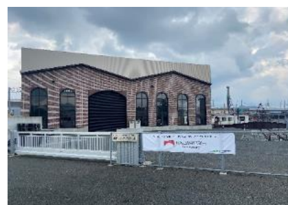
盛岡車両センター SL検修庫
