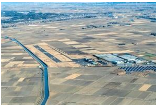
▲上空から見た竜ヶ崎飛行場全景
