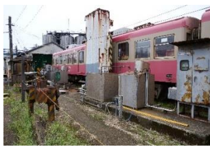
【銚子電鉄 車体洗浄装置】
