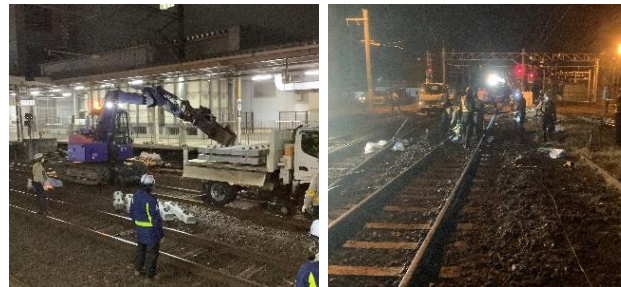
【秋田駅】線路工事（イメージ）
