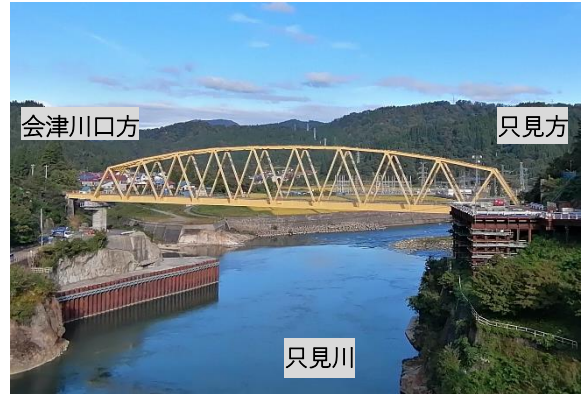
桁架設及び軌道工事完成
