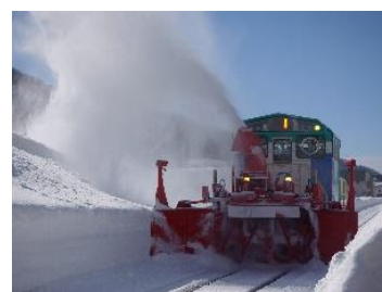
除雪機械による除雪作業
