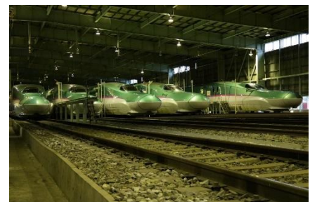
盛岡新幹線車両センター
