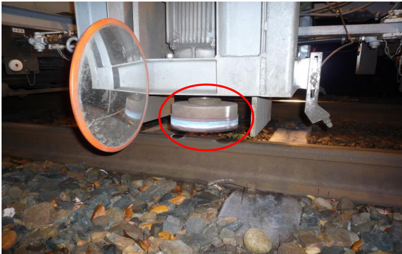
【レール研磨作業(砥石)】
