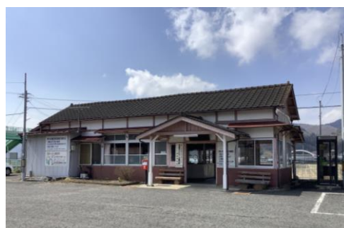
東館駅舎 外観
