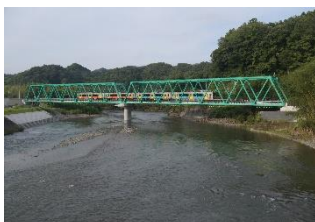
第6久慈川橋りょう付近
