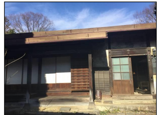
修理を行う玄関周り
