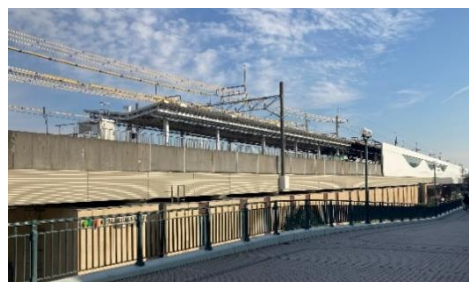
【② 東京方面 新設ホーム上家写真】
