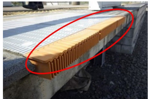
車両とホームのすき間縮小のためのくし状部材
